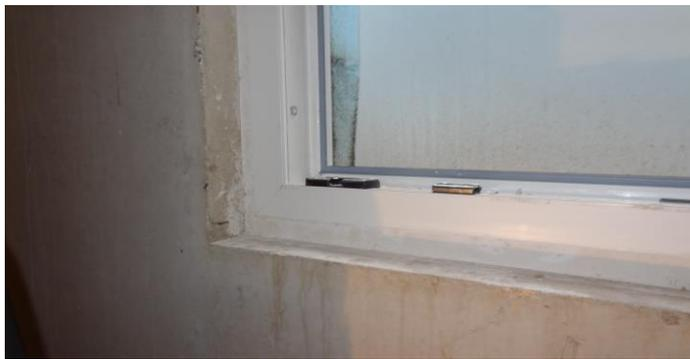
*Innere Fuge zwischen Fenster und Rohbau zugespachtelt*
