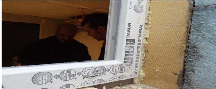
Seitliche Fuge außen ungeschützt, keine Abdichtung, Fehlstellen im Schaum, fehlende Abdichtung der Fensterbank
