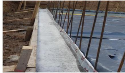
*Anschlussbewehrung direkt am Dichtprofil*
