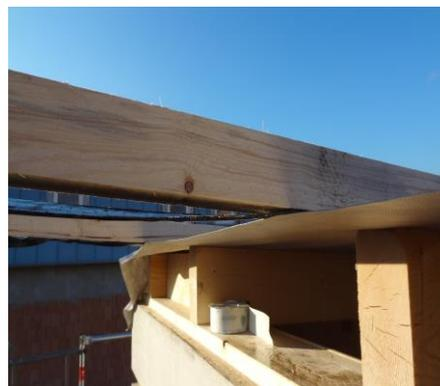
Unterdeckbahn, Konterlattung mit Dichtband
