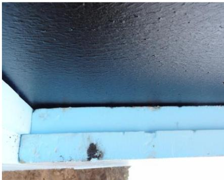
Abdichtungsauftrag ab 100cm über Bodenplatte
