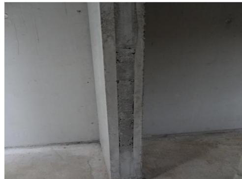
*Kiesnest über der Anschlussmischung (Lager)*
