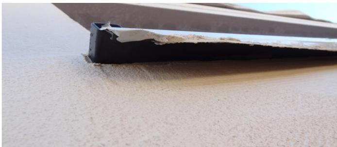
Mit Dichtband gefasste Fensterbank
