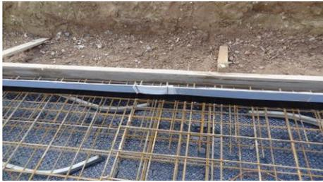
*Stoßstelle Dichtprofil (geklammert, überlappt)*
