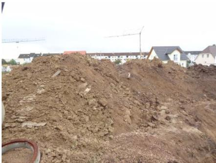
*Aushubmaterial, zur Wiederverfüllung ungeeignet*
