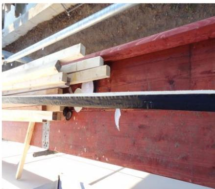
Konterlattung mit Dichtband
