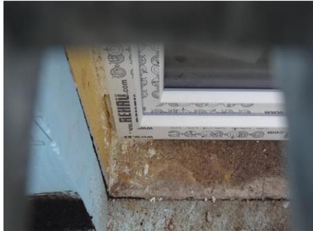
*PU-Schaum oberflächlich verwittert (fehlende UV-Beständigkeit)*
