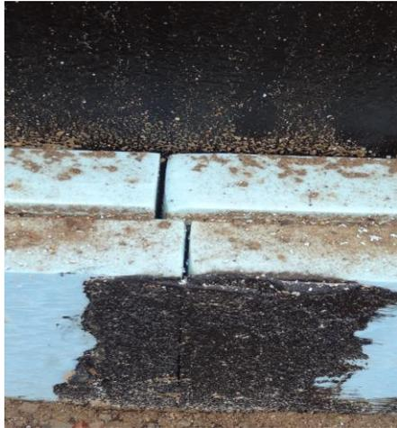
*Gebrochene Abdichtung über Plattenstoß*
