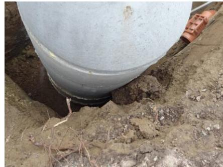
Eingebrochene Baugrube am Schacht
