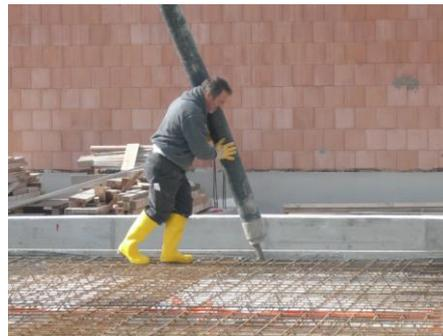
*Frei Fallhöhe > 1,00m beim Betoneinbau*
