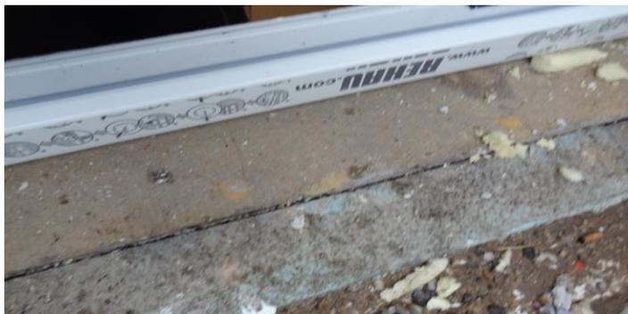
fehlende Abdichtung der Fensterbank, ungelöster Übergang Dämmung zum Element, hoch anstehender Schutt im Lichtschart
