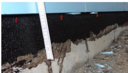
*Fuge zwischen Bodenplatte und Dämmung*
