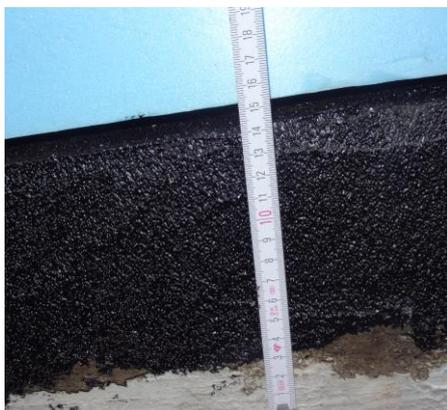
*Unvollständige Abdichtung der Bodenplattenkante*
