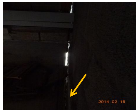
Öffnungen am Giebel im Anschluss an Bestand
