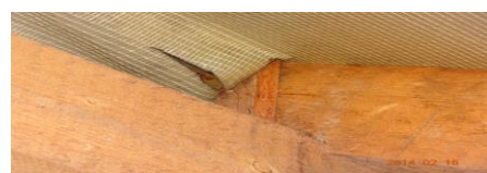
fehlende Luftdichtigkeit
