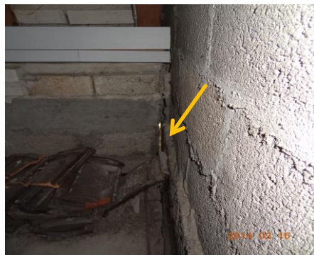
Öffnungen am Kniestock im Anschluss an Bestand
