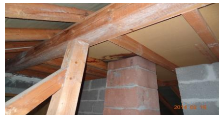
Holzplatten unter Spitzboden
